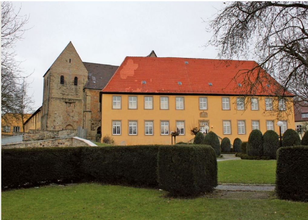
Nach der Aufklärung leerstehende Klöster, wie hier das der ehemaligen Benediktinerinnen in Osnabrück, wurden zu Heil- und Pflegeanstalten umgewandelt.
